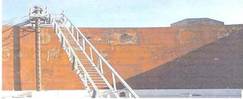
شكل (1) يوضح التآكل العام لأحد الخزانات
