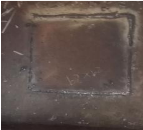
شكل (15) يوضح معالجة المنطقة المتآكلة باللحام
